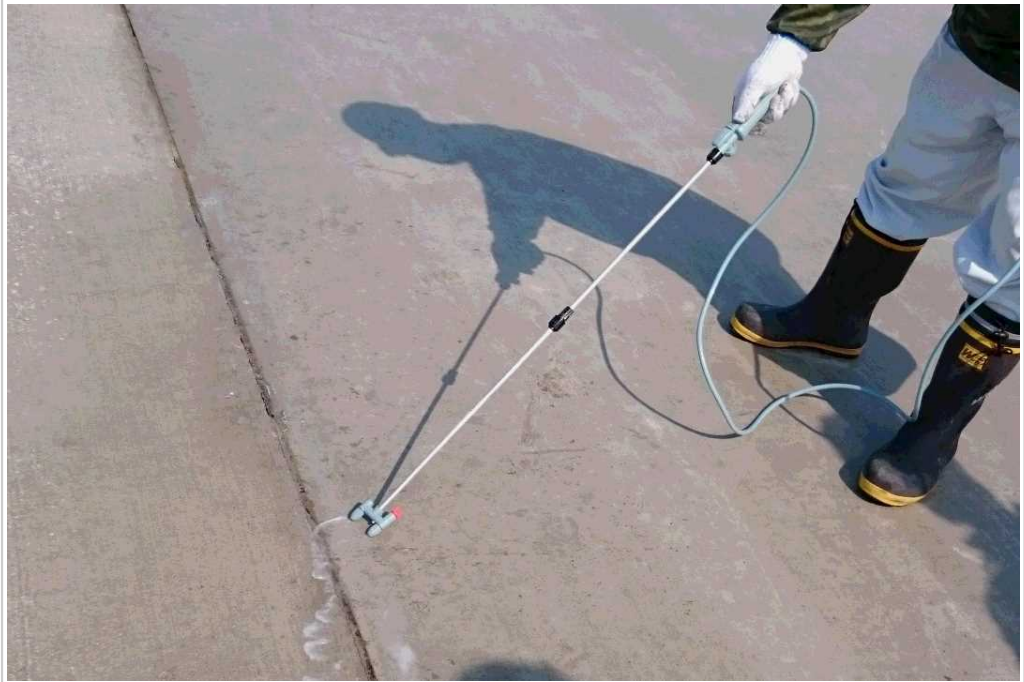
施工状況等の写真2
