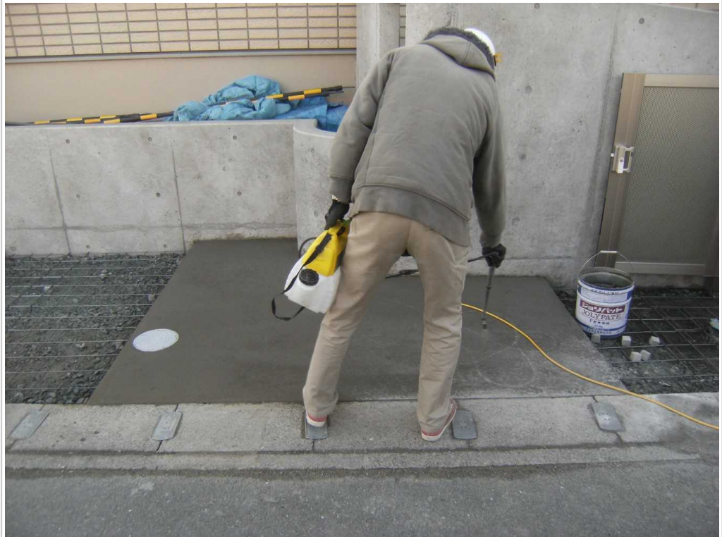
施工状況等の写真2
