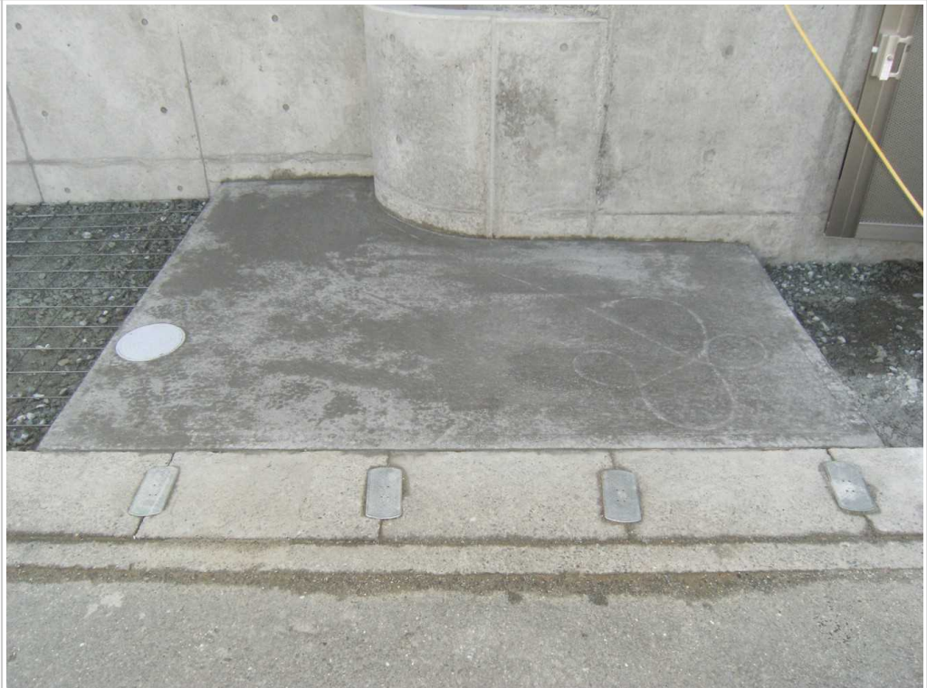
施工状況等の写真3
