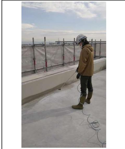
散水洗浄した水を回収しています。
