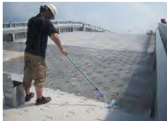
③表面のヌメリや残材を、たっぷり散水しながら、デッキブラシで除去洗浄して完了
